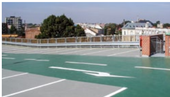
Polyuretanové systémy, Parkovací dům Opava
